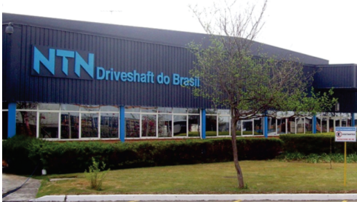
Fábrica de Semieixos Guarulhos/SP
